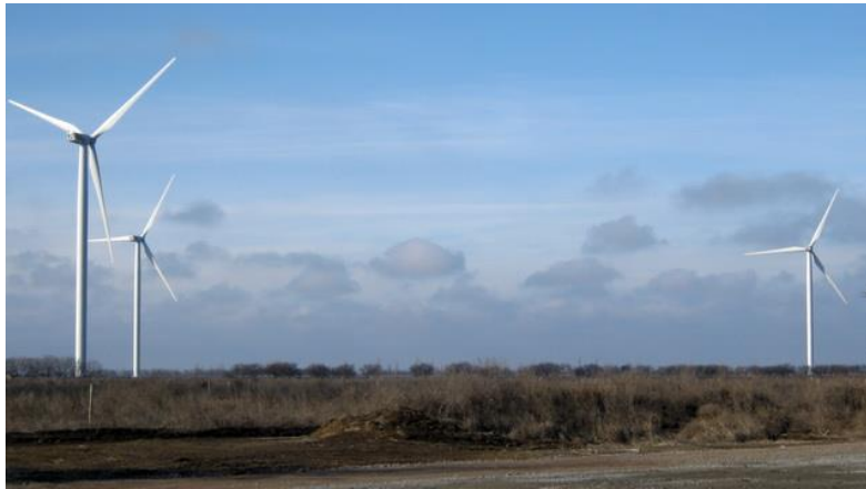
Рис. 1. Вітряна електростанція «Вітряний парк Очаківський»
