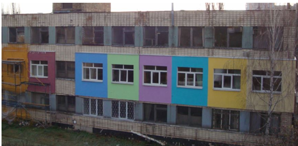
Рис. 2. Загальний вигляд досліджуваної будівлі з різноваріантною тепловою ізоляцією зовнішніх стін
