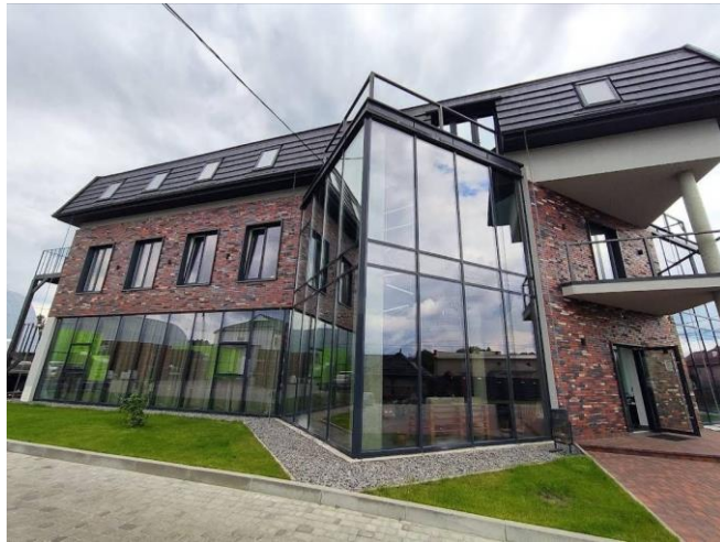
Рис. 2.2. Фото фасаду будівлі
