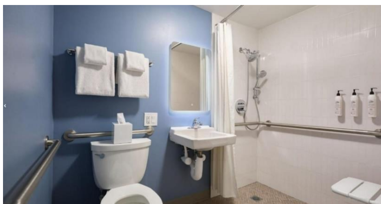
Рис.2.8. Обладнання санвузла, Delta Hotels By Marriott, New York
