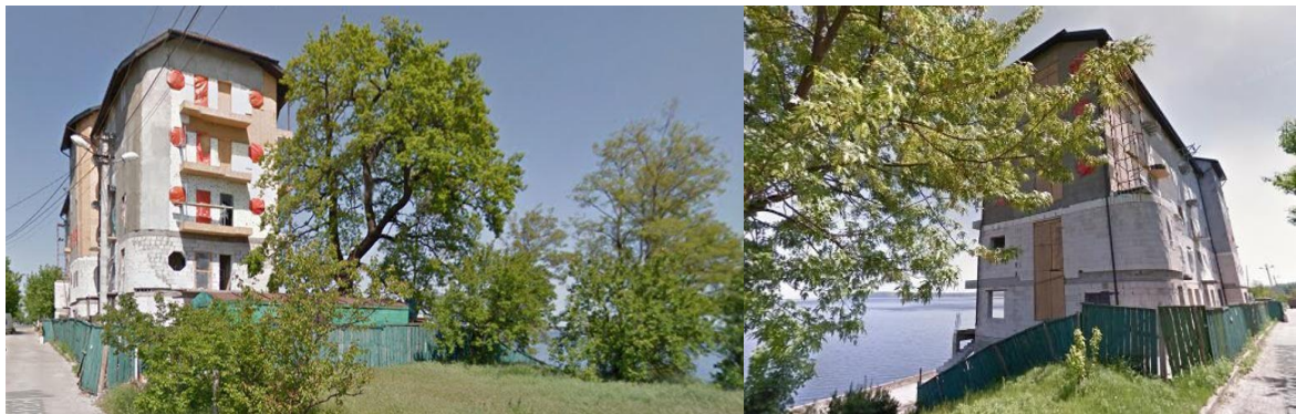
Рис.2.3. Фото готелю в процесі будівництва
