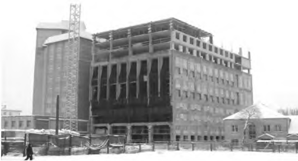
Рис.8. Реконструкція незавершеного будівництва виробничого корпусу під адміністративну будівлю з приміщеннями громадського призначення та вбудованим гаражом-стоянкою та багаторівневою гостьовою автостоянкою з об'єктами обслуговування (вул. Зм. Бядулі, м.Мінськ, Білорусь).
